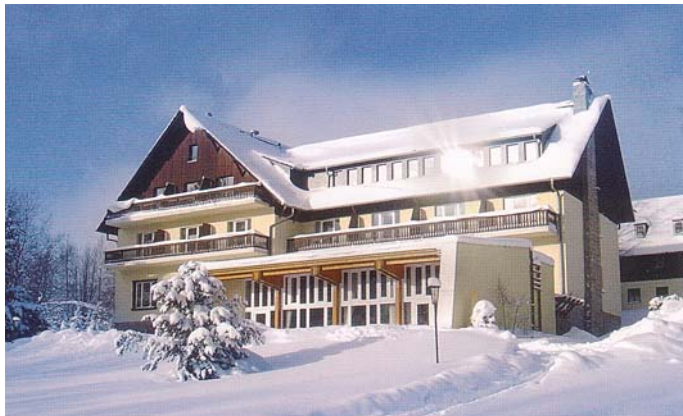
Haus am Ahorn, Kottenheide, Vogtland
